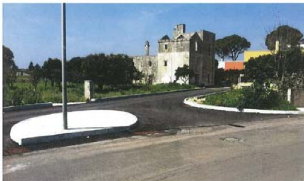
VISTA DELL' INCROCIO TRA VIA NENNI E NUOVA STRADA
