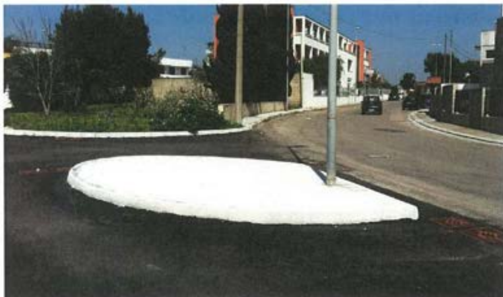
VISTA DELL' INCROCIO TRA VIA NENNI E NUOVA STRADA
