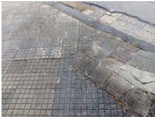
Pavimentazione degradata
